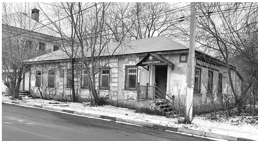
Рис. 6. Тверь. Троицкая, 1. Жилой дом второй половины 1770-х гг., восточный фасад которого сохранил немало элементов первоначального позднебарочного декора. 1 марта 2025 г.
